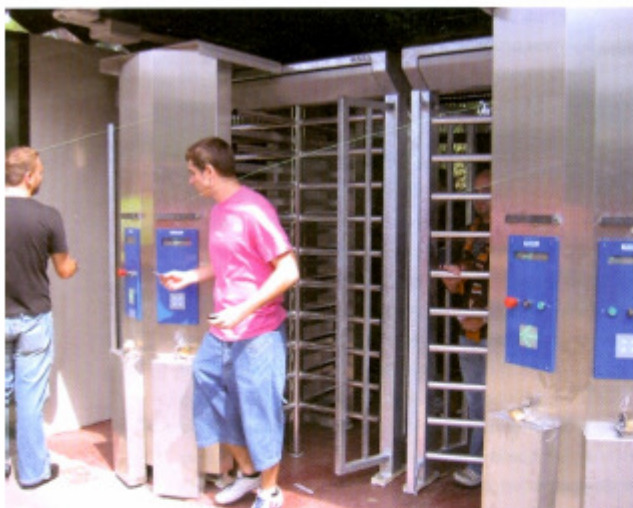
Il sistema integrato di controllo e gestione accessi allo stadio Olimpico di Roma si avvale di turnelli concordanzi in modo completamente automatizzato da un sistema hardware e software (Doc. Zucchetti).
